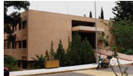
Κτίριο Βιβλιοθήκης ΕΚΕΦΕ «Δημόκριτος», Αθήνα
